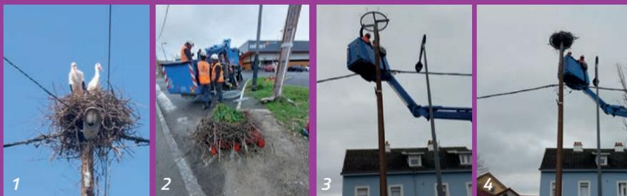
1. Nid de cigognes sur poteau béton, 2. Dépose du nid, 3. Installation d'une plateforme, 4. Repose du nid
