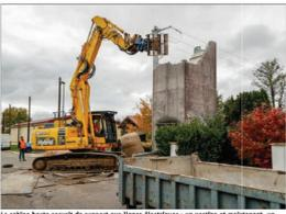
La cabine haute servait de support aux lignes électriques. Le transformateur est en cours de démolition.
