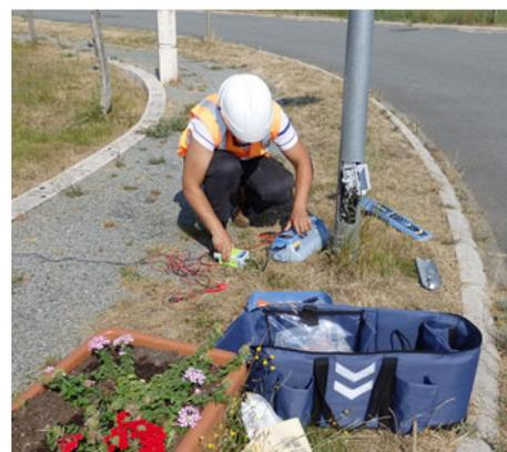
Géo-détection des réseaux et des points lumineux
