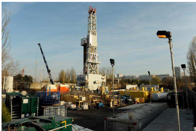
La foreuse de 40 mètres de haut, va réaliser, jusqu'en février 2014, deux forages successifs à 1600 mètres de profondeur
