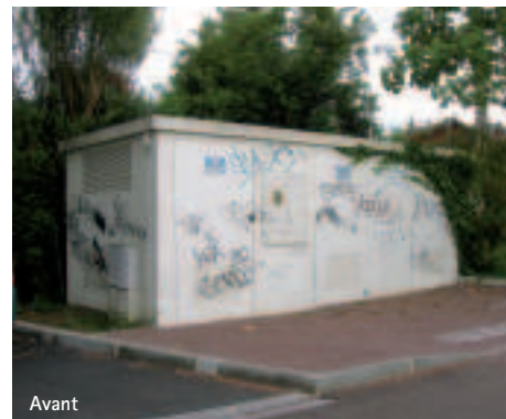
Rénovation du poste de transformation à Blonville-sur-Mer
