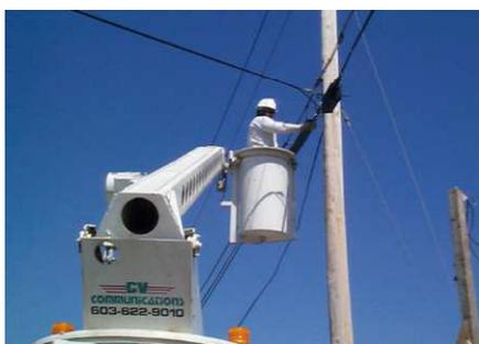
Recommandé par EDF, le déploiement de câbles autoportés est particulièrement adapté pour le déploiement sur réseaux BT/HTA
