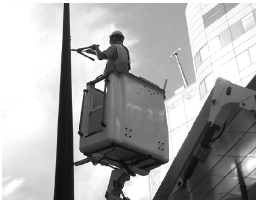
Implantation de nouveaux luminaires avec réducteur bi-puissance
