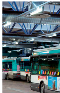
Centre bus de Pavillons sous Bois : Expérimentation économie d'énergie système automatique d'éclairage dans l'atelier de maintenance des autobus
