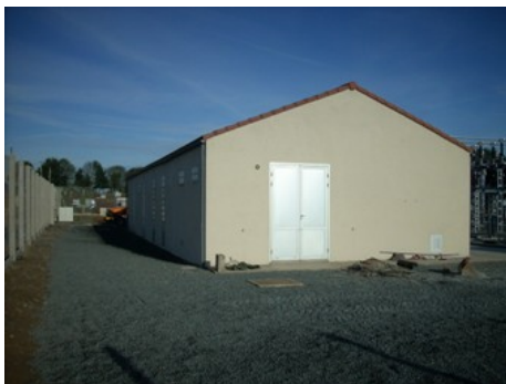
Le bâtiment de commande d'où les installations sont surveillées par des équipements informatisés.
