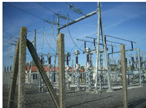
La clôture qui empêche toute intrusion dans le poste.
