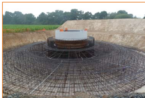
Fondations du parc éolien de Lamballe
