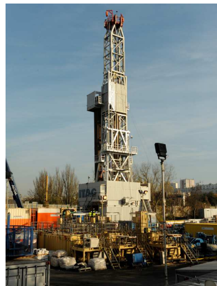
Forage au Dogger à environ 1 830 mètres, pour récupérer une eau à 64°C.
