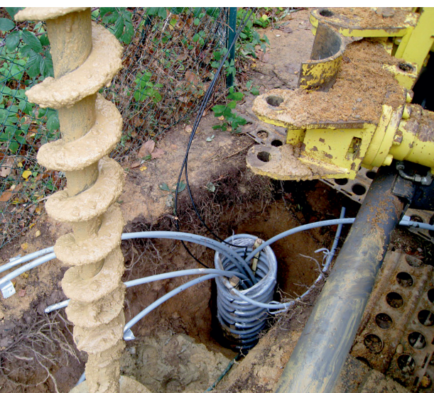
Des échangeurs type « corbeille » sont testés dans le cadre du projet Micro-Géo. © BRGM
