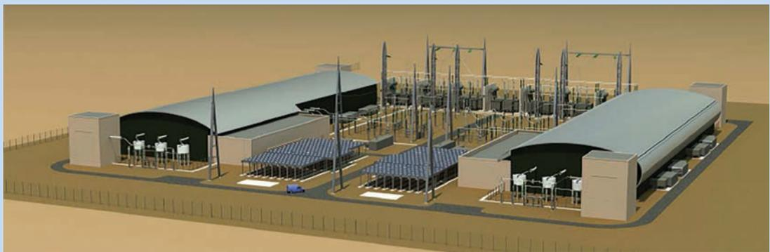
Présentes à chaque extrémité de la ligne, les 2 stations de conversion de Baixas (France) et Santa Llogaia (Espagne) jouent un rôle majeur pour l'interconnexion : moteurs de la technologie VSC (Voltage Source Converter), elles permettent de convertir le courant alternatif en courant continu et inversement. Chaque station accueille plus de 5 000 modules de puissance qui réalisent cette conversion.
