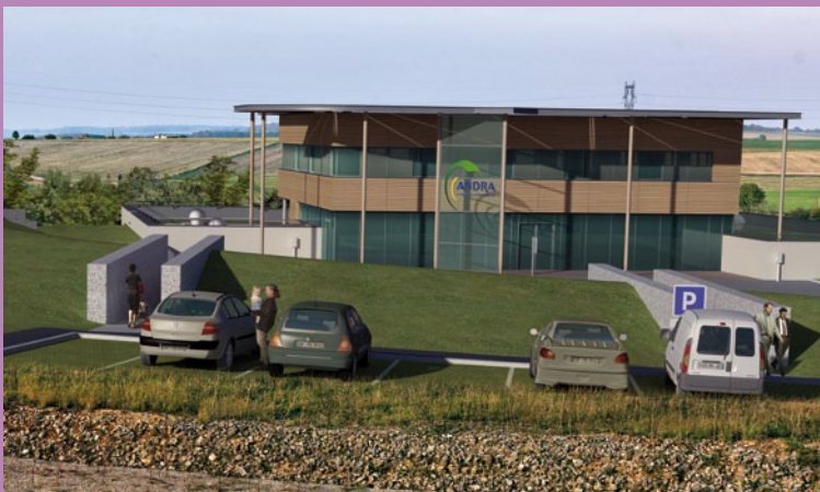
Tour d'observation des flux dans la forêt de Montiers-sur-Saulx, Station de mesure atmosphérique à Houdelaincourt, Future écothèque pour la conservation des échantillons (en construction)
