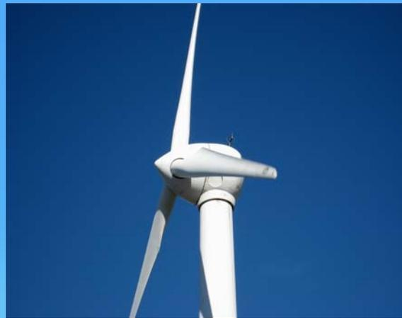
Eolienne équipée d'une nacelle SOFTWIND à attaque directe
